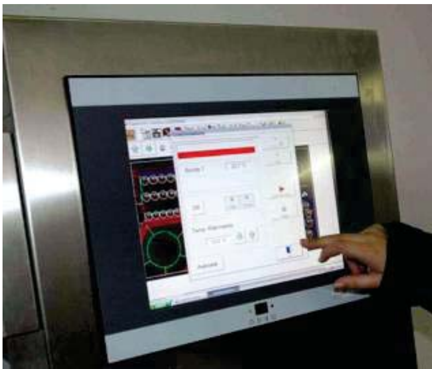
>> Unità di controllo centrale per il monitoraggio e la gestione dei dispositivi posti sui serbatoi.
